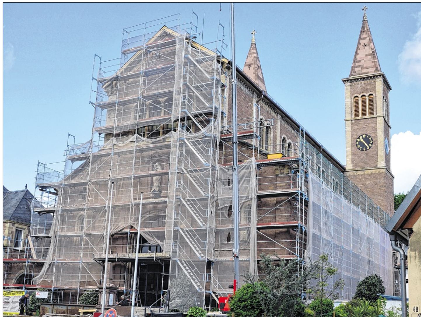
DIE RENOVIERUNG der Bulacher Kirche St. Cyriakus ist schon weit gediehen. Während die beiden Türme und das Hauptschiff bereits fertig sind, wird an den Seitenschiffen und an der Fassade beim Hauptportal noch gearbeitet. Fotos: Jock
