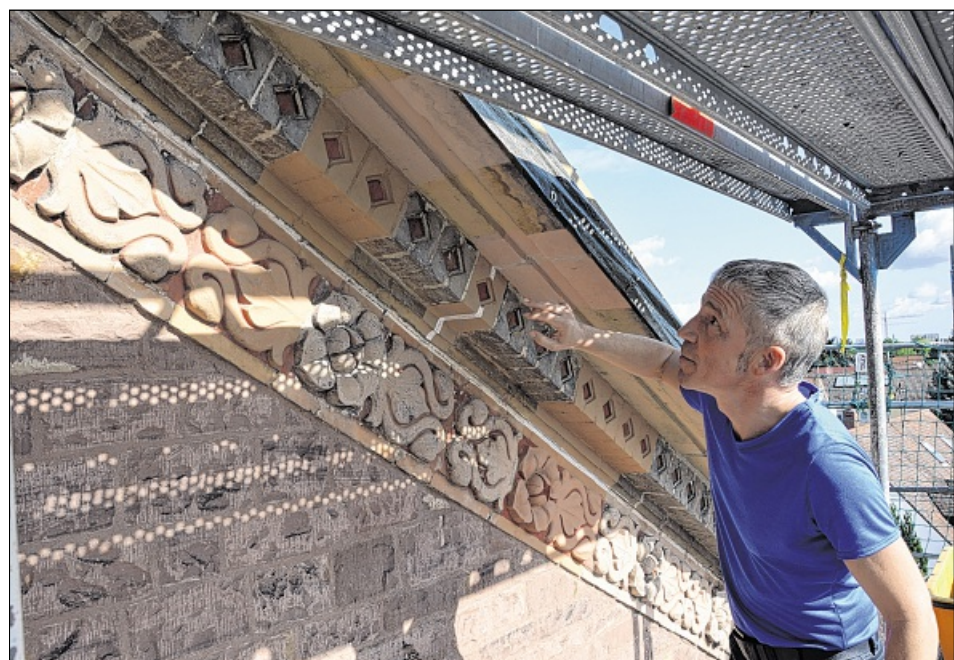
ÜBERRASCHEND BUNT war die Fassade einst, weiß Pfarrer Thomas Ehret. Freigelegte Reste und Farbproben direkt unterm Kirchendach geben einen Vorgeschmack.
